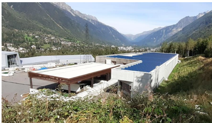
Centrale photovoltaïque du CTM – Chamonix-Mont-Blanc
