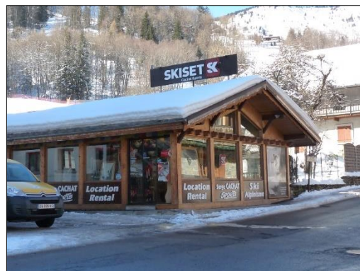
enseignes apposées à plat sur façade et irrégulièrement installée en toiture (panneau de fond)
