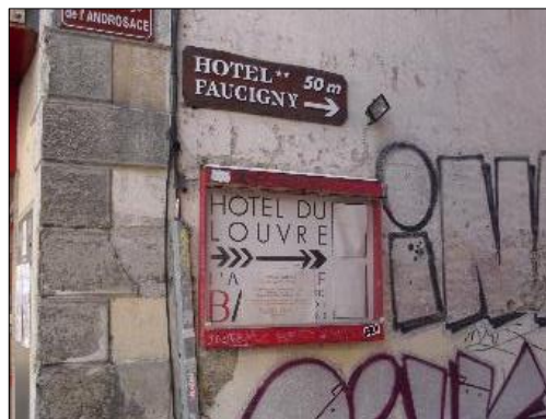
Préenseignes irrégulièrement installées sur une façade non aveugle
