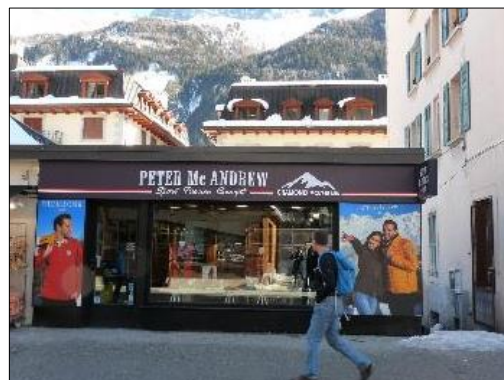
enseignes irrégulièrement apposées à plat sur façade (surface > 25 %)
