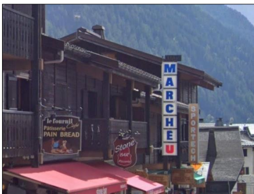
enseignes irrégulièrement apposées perpendiculairement sur façade ou balcon
